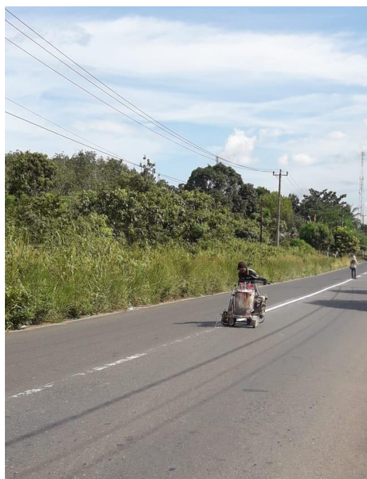
Pengecatan marka jalan
